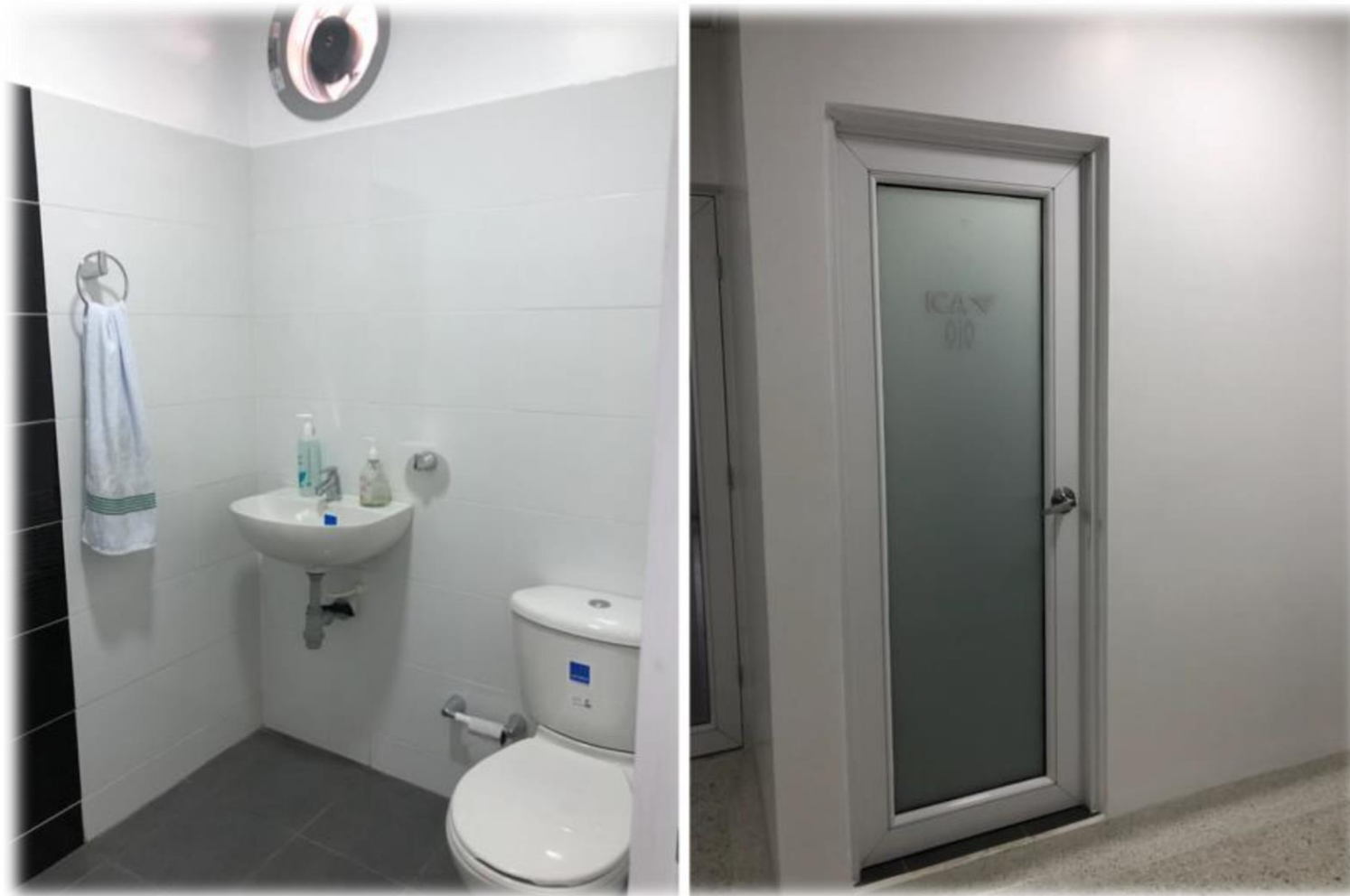
Adecuación de la batería sanitaria.
