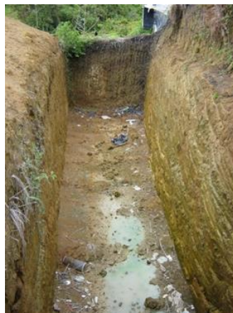
Figura N° 1. Fosa para el enterramiento de aves.
