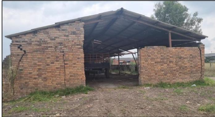
Agrietamiento Edificación lote 35 con solicitud de demolición
