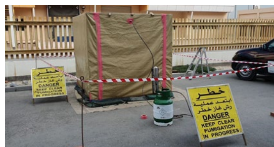
Fumigación de embalaje de madera en Bahrein
